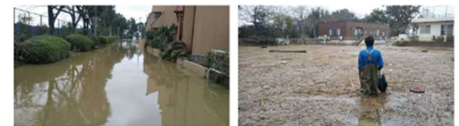
(写真2) 発災直後のH施設(敷地内)
